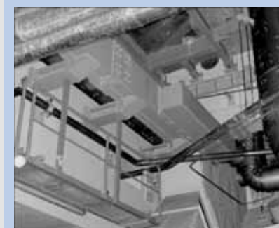
Laserscanning ist unabhängig von der Ausleuchtung und auch in völliger Dunkelheit einsetzbar. (oben: professionelles Panoramafoto. unten: s/w Laserscan)
